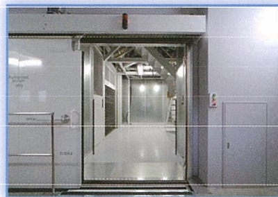
10m法電波暗室の広い搬入口
