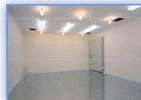
シールドルーム内部
