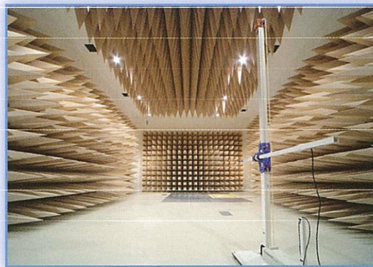
10m法電波暗室内部
